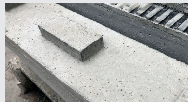
Zadrževalni bloki iz betona, ojačanega z vlakni.
